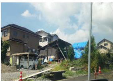
崩れてビニールシートで覆われた家
